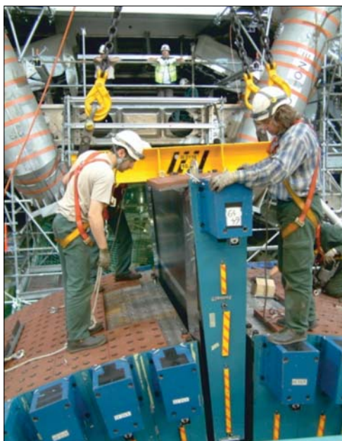
Рис. 3.32. Вверху: сборка барреля из дубненских модулей на поверхности завершена 30 октября 2003 г. Внизу: установка последнего, 64-го модуля при сборке в шахте короткого барреля. 23 мая 2006 г.
