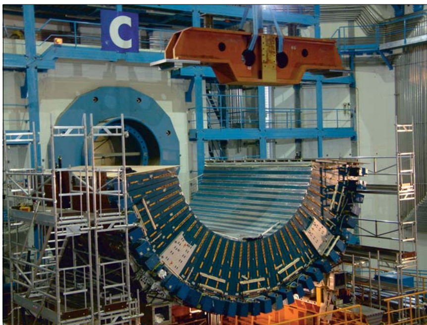
Рис. 3.33. Этапы сборки второго (центрального) барреля: на поверхности (вверху) и в шахте (внизу)
