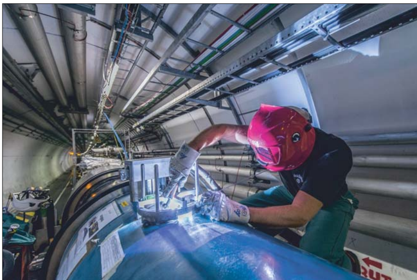
Рис. 3.114. Установка фланца крепления клапана аварийного сброса давления в тоннеле LHC
