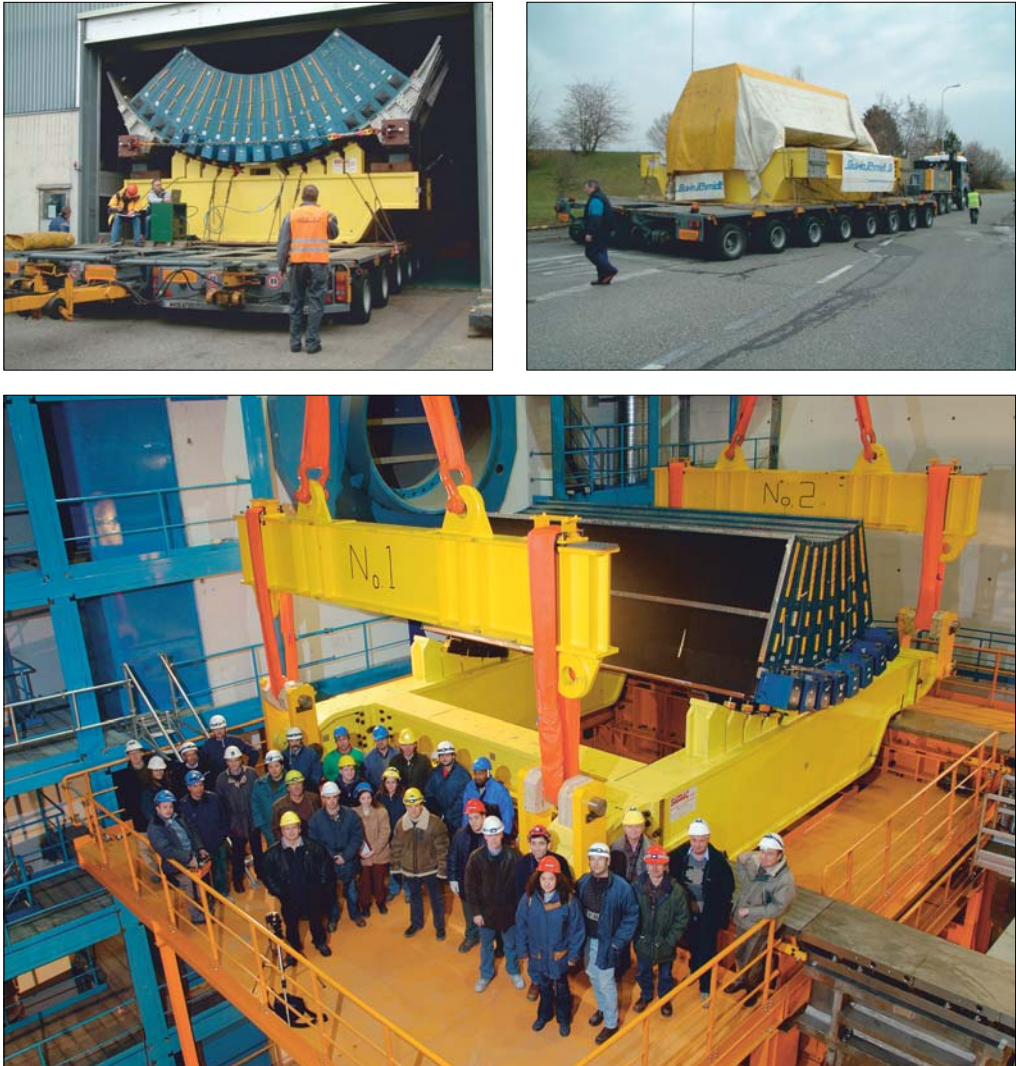
Рис. 3.35. Этапы транспортировки баррелей в шахту ATLAS
